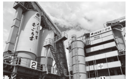
ここでアスファルトが練られてつくられているんだ！約180℃もあるんだって！
